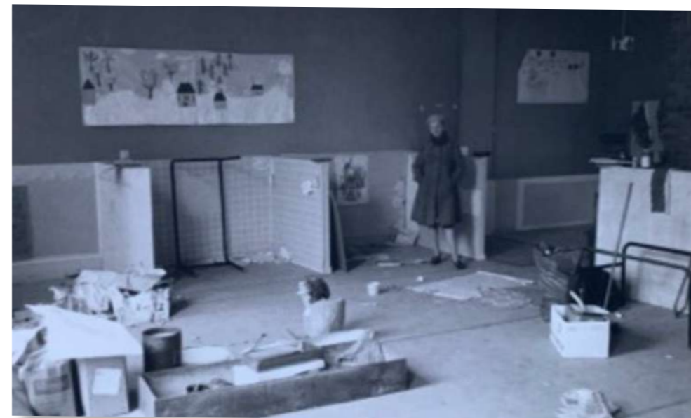
Ancienne salle de classe dans le bâtiment M ou N
